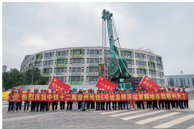
公司监理的常州地铁5号线皇粮浜站首幅地连墙顺利开工
