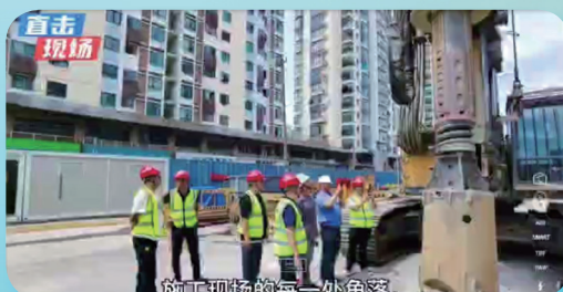
无锡地铁5号线一期 土建二标项目
